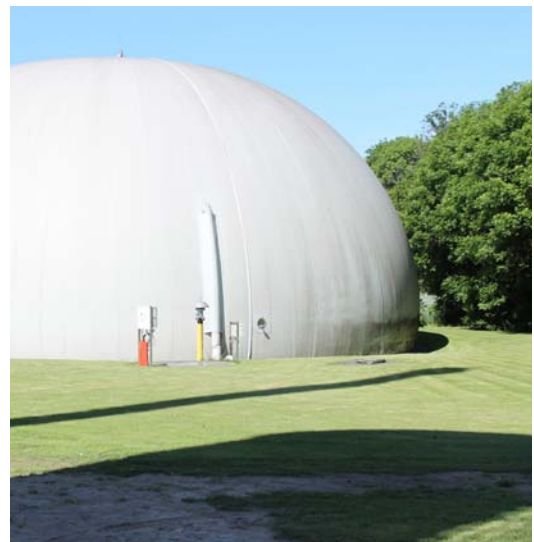
Linkogas, Rødding, gastank på et fælles biogasanlæg.
