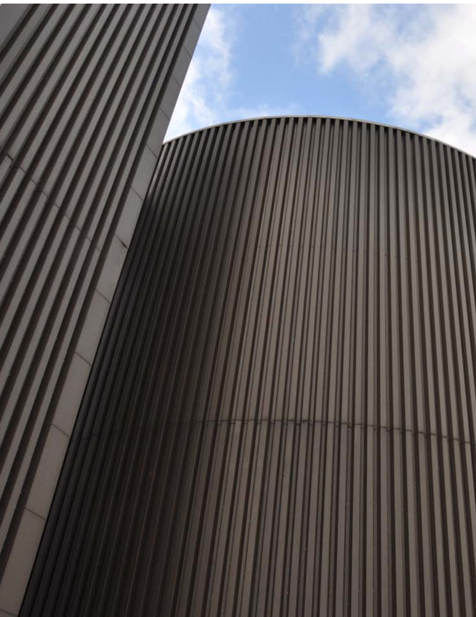
Rådnetanke (Fredericia Kommunale rensningsanlæg).
